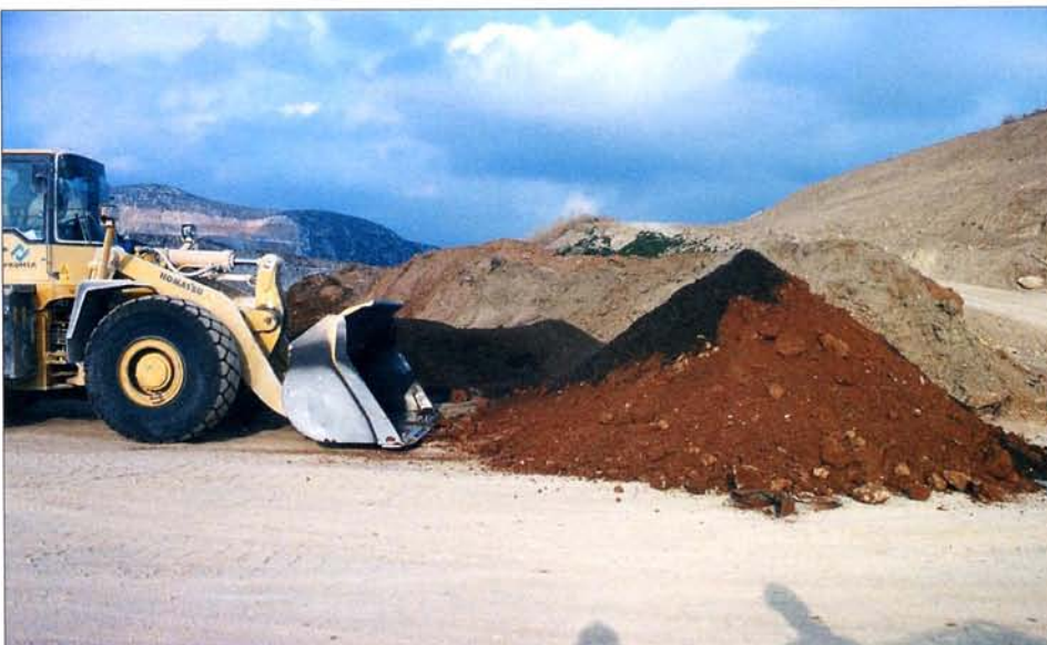
Detalle de la mezcla de compost con las tierras externas en Falconera.
