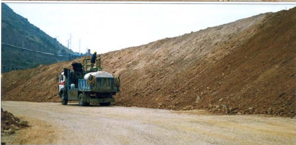
[Fig. 2]. Hidrosiembra en "Fou" (arriba) y en "Vallcarca" (abajo).
